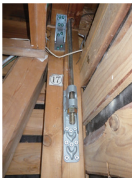
(5) 柱頭柱脚金物 (上部左側)
