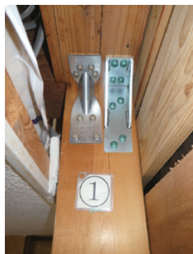
(13) 柱頭柱脚金物（上部右側）
