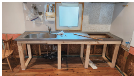
図-8 乾燥後の仮設台所
