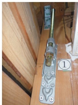
(12) 柱頭柱脚金物（上部左側）
