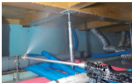
図-6 床下に DOT+SDIC 水溶液を噴霧処理
