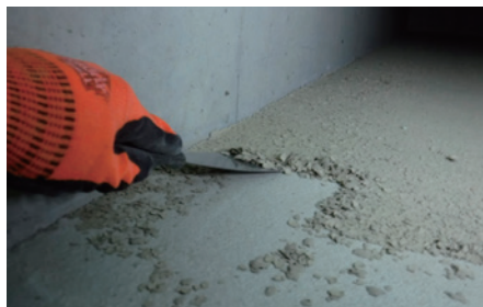
図-5 スクレーパーで乾いた泥を剥がす
