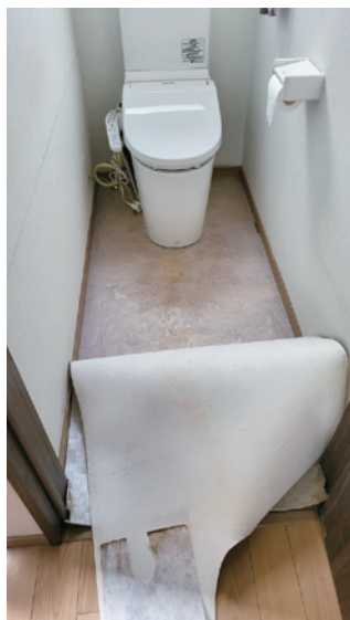
図-3 ビニールシートの撤去
