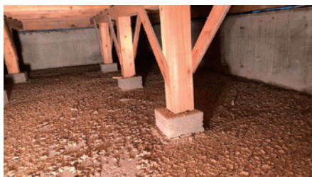
図-7 乾燥後の床下空間
