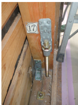
(4) 柱頭柱脚金物 (下部右側)
