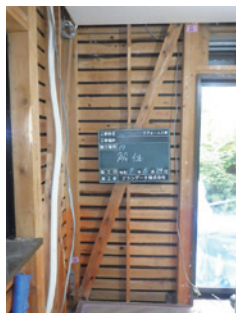
(3) 解体既存筋交有り
