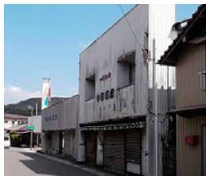
1年半前の調査では活用可能だった空き家
