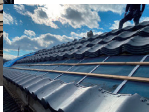
左：屋根 構造用合板で補強 右：瓦葺（乾式）
