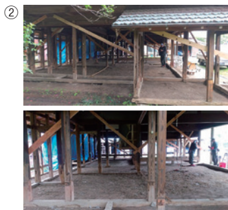
② 壁・床の撤去
