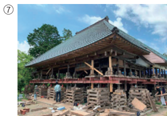
⑦ 作業中の外観
