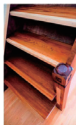
急勾配の階段には、段鼻に木材を追加し視認性を向上させた。
