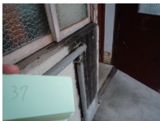
外廊下にはガス管や給排水管、電気配線が入り組みメンテナンスできない状態。 雨だれによる汚れや板金の錆など、全体的に劣化が目立つ
