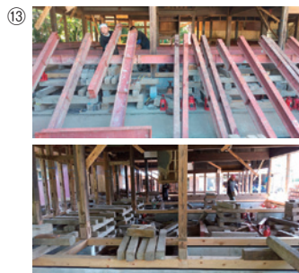
仮設鋼材・枕木の撤去
