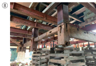
⑧ 作業中の内観
