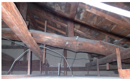
施工前の2階小屋裏（目立った劣化は見られない）
