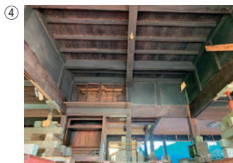
④ 施主要望による神棚の保全のための細工
