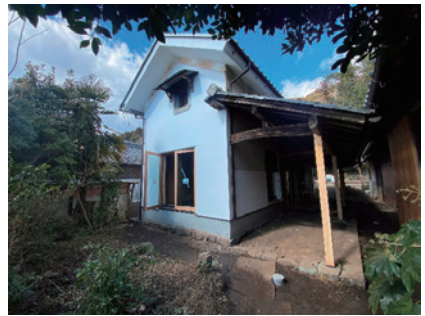
ほぼ土壁となっていた蔵の外壁は、補修の上、漆喰仕上とした
