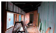
断熱材は処分考慮し乾式
