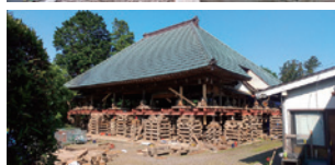
⑨ 作業中の内観基礎・土台築造の ために枕木を組みなおす
