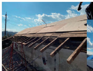
左：屋根 構造用合板で補強 右：瓦葺（乾式）
