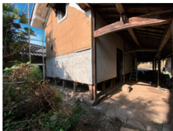
利用可能な土壁は残して解体
