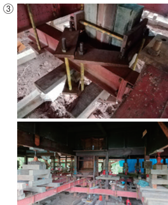
③ 添え柱・ジャッキの据え付け
