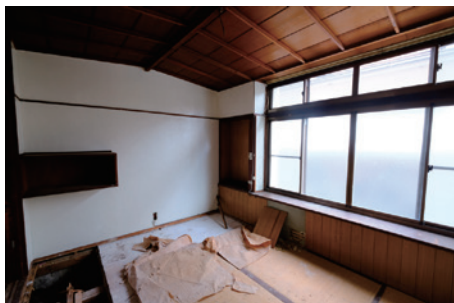
漏水跡も複数あり、無筋の基礎には蟻道も見られた。 外壁にも断熱材が施工されておらず、開口部は木製建具（廊下側）と一部アルミサッシ（居室側）。 消防法にも適合していない状態
