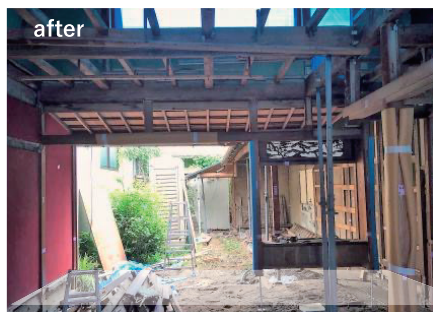
大引下でH386を確保し、床下換気・点検が可能とした
