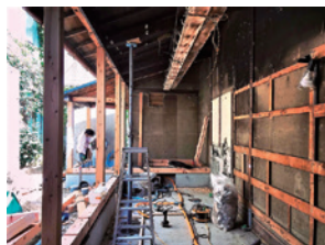
立上り脱型後に土台・新設柱を立てる。全ての構造材が入った後に支保工解体 スリーブ穴をコンクリートで埋める
