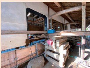
基礎打設の為に建物を浮かす
