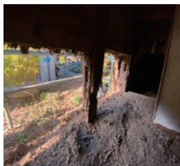
柱脚の腐朽
