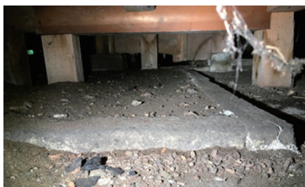
施工前の床下内部（外周部以外は基礎らしい基礎はない）
