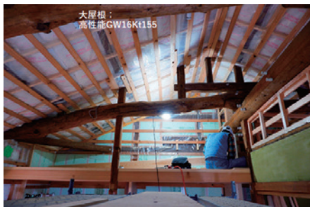
屋根への高性能グラスウール断熱材の充填状況
