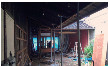
支保工で屋根を支える
