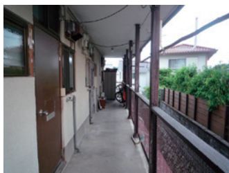
外廊下にはガス管や給排水管、電気配線が入り組みメンテナンスできない状態。 雨だれによる汚れや板金の錆など、全体的に劣化が目立つ
