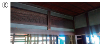
⑥ 揚家途中 (垂れ壁等にダメージがないことを確認)
