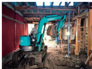
建物内の整地
