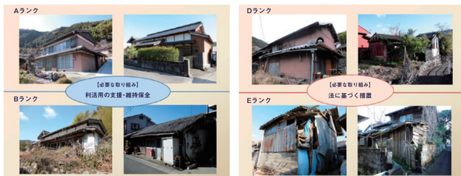
図-5 空き家の劣化ランクごとの物件イメージ
