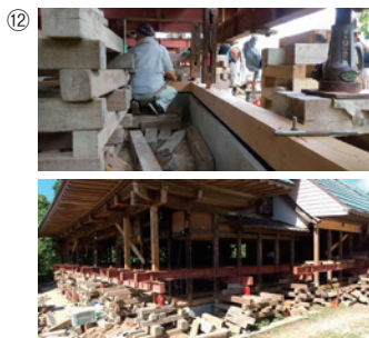
微調整を行いながら据え付け
