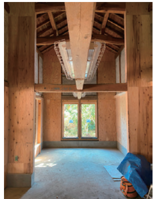
内部は構造用合板仕上げとし、必要に応じた仕上げが可能
