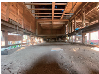
基礎部分の解体
