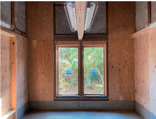
内部は構造用合板仕上げとし、必要に応じた仕上げが可能
