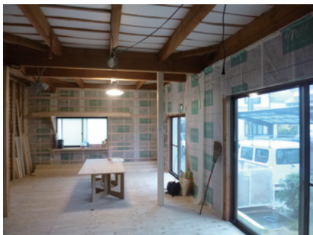
セルローズファイバーの施工
