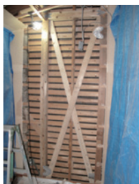
筋かい30×90 ダブルに設置
