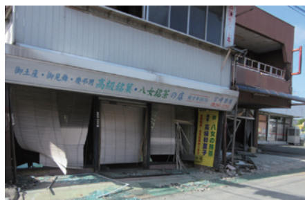
写真-14 2階が重い建物(突起した2階)
