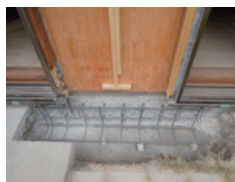
ツイン基礎 (布基礎に緊結させて 鉄筋入りの基礎を補強)
