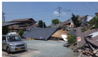
写真-25 住宅地の被害
