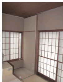
室内壁仕上げ
