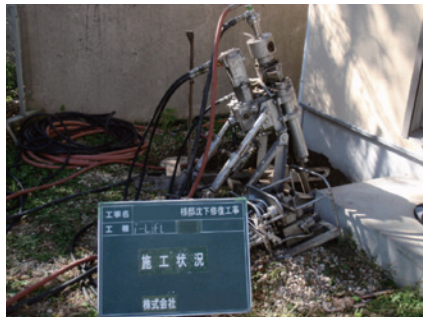
建物外周からの注入例(ボーリングマシン使用)
