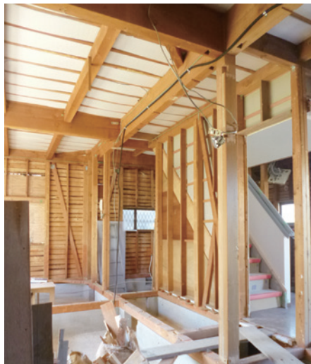
耐震金物施工中
