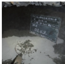
①耐圧版下部地盤補強
