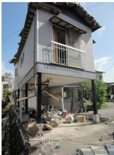
写真-13 1階にほとんど壁がない建物
