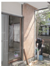
外壁側から構造用合板 (大壁仕様)を張る
