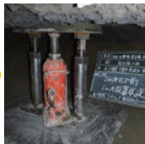
④ジャッキ設置・加圧
