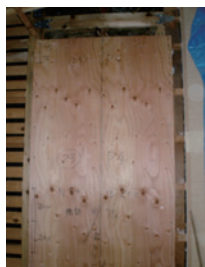
構造用合板(非耐力壁仕様)を張る
