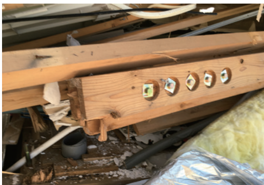
写真-16 アンカーボルトのない基礎
