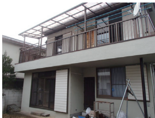
南外観(施工前)
