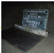
②耐圧版設置
