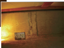
エポキシ樹脂注入完了
