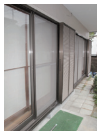
竣工 基礎補強完了
