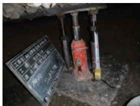
②ジャッキアップ完了
