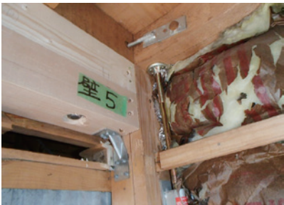
梁の段差調整後柱頭金物の設置
