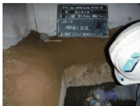
埋め戻し状況
