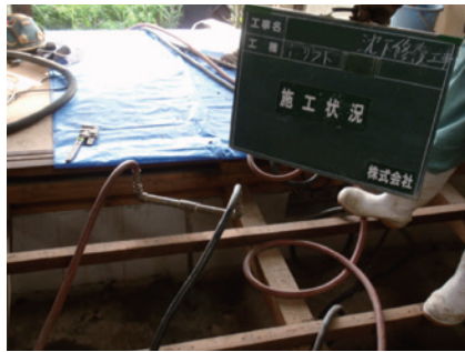
建物内部からの注入例(人力にて注入管挿入)
