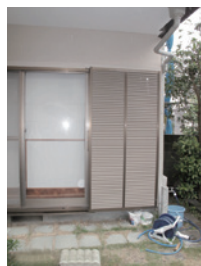
外壁仕上げ戸袋設置 (補強前の状態に復帰)
