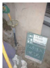
セメントミルク注入作業
