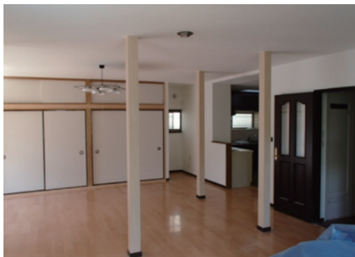
和室を間仕切り撤去、食堂に変更完了
