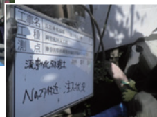
流動化処理土注入
