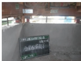
ライナー設置・配筋
