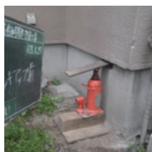
①ジャッキセット状況
