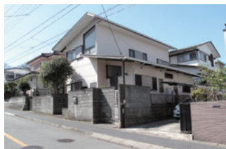
2階は急な屋根勾配に合わせた斜め天井、階段ホールには大きなガラス窓
