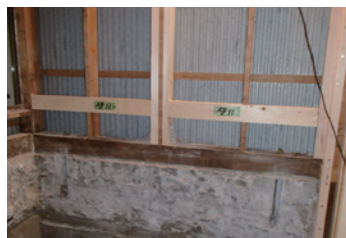
浴室解体耐震下地
