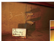
エポキシ樹脂注入
