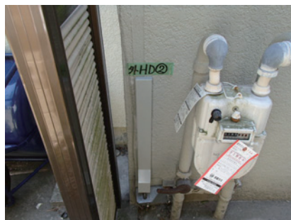
外付ホールダウン金物設置
