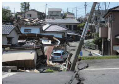
写真-4 液状化による被害
