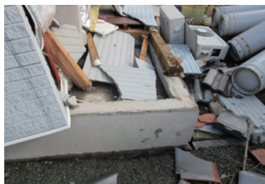
写真-16 アンカーボルトのない基礎
