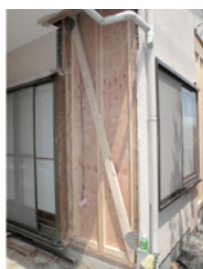
外壁側から筋かい補強 (戸袋・外壁撤去)
