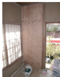
室内側に構造用合板 (真壁仕様)を張る
