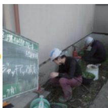
②ジャッキアップ
