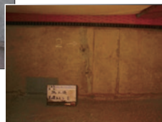
エポキシ樹脂注入完了
