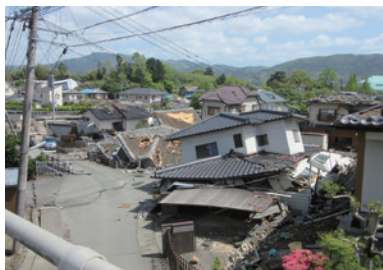
写真-1 扇状地内の被害
