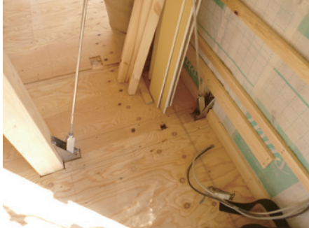
耐震ブレースの設置
