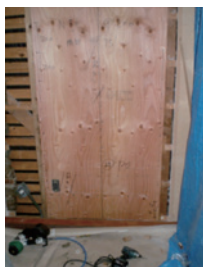
構造用合板(非耐力壁仕様)を張る
