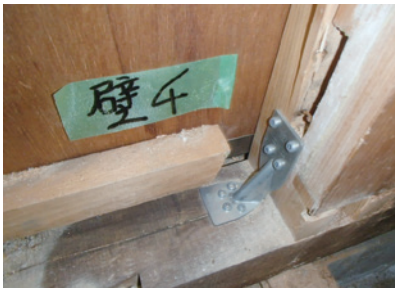
柱脚金物の設置
