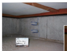
エポキシ樹脂注入
