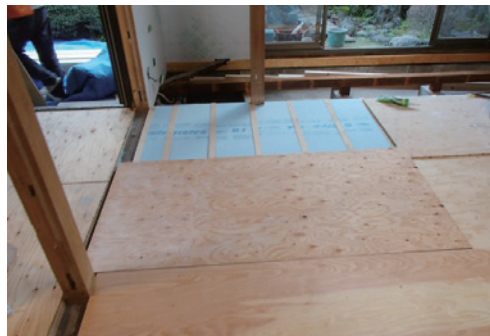
床断熱材設置
