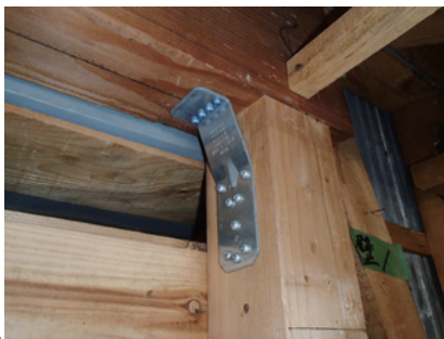
柱頭金物設置
