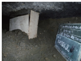
型枠・埋め戻し状況
