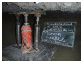
①ジャッキアップ前
