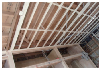
和室押入れ天井解体
