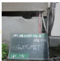
③ジャッキアップ完了
