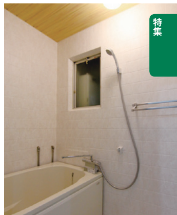
浴室壁・床にフィルムシートを施工
