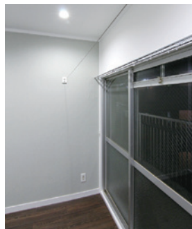
室内用物干しを設置
