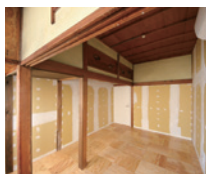
室内の柱や欄間などは再利用して昔の面影を残し、内装にはあえて手を入れず、入居者が好みの塗装ができるようにして引き渡した（D）
