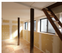
室内の柱や欄間などは再利用して昔の面影を残し、内装にはあえて手を入れず、入居者が好みの塗装ができるようにして引き渡した（D）
