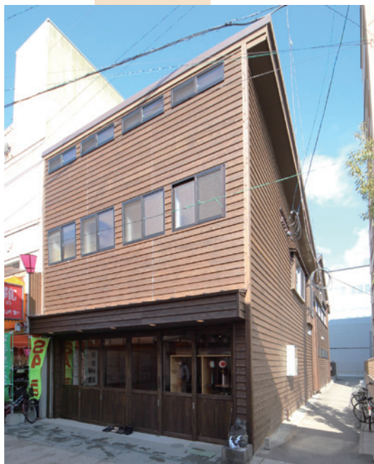
明治初期に建てられた当時の連窓が外壁の下に隠れていたのを、竣工当時の姿に復元した（外観）
