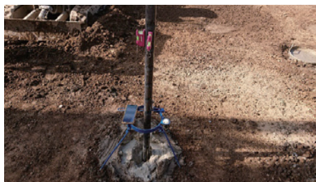
• 段付銅管建て込み
