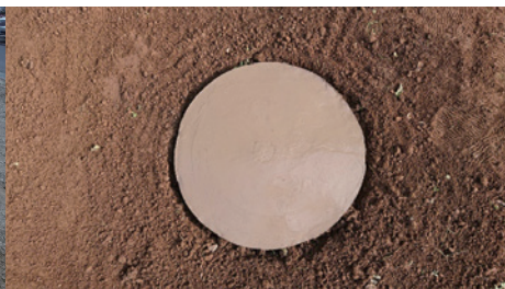
• 施工後（施工箇所）
