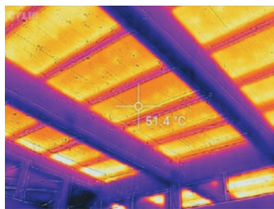
写真-1 屋根裏のサーモグラフィー
