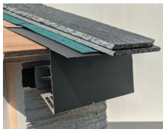
図一-4 軒裏換気部材の例
