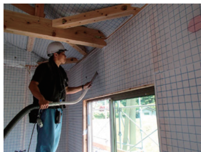
図-1 セルロースファイバーによる断熱
