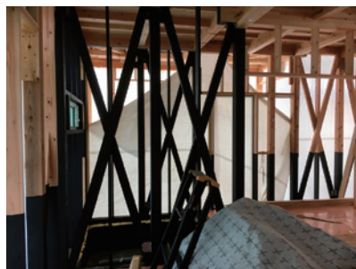
図-2 備長炭による防蟻処理
