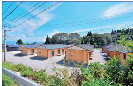
熊本地震後に建設された黒川仮設団地（阿蘇市）。あたたかみのある木の外観が目を引く。
