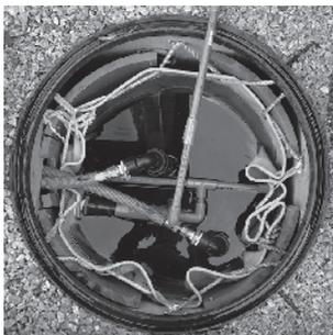
コンクリート柵とG-カーペットを格納した防水シートを使用した熱交換用タンク。(高杉邸)
