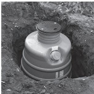
内部にG-カーペットを格納したタンク。汲み上げた地下水と熱交換。(ヤマコトラストホームズ)
