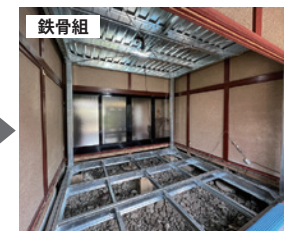
鉄骨組 構造柱と梁の内側に 鉄骨を組立て
