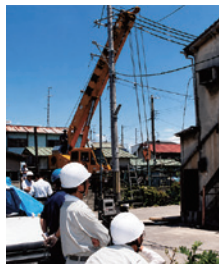
クレーン車による強度実験
