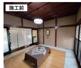
施工前 和室の床と天井を解体 (建具をそのまま残して施工)
