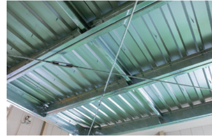
天井全面にキーストンプレート筋交いプレスで耐震性を向上
