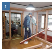
土台・柱・桁周りの組み立て
