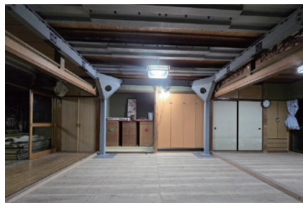
施工事例（まもルームスリム）
