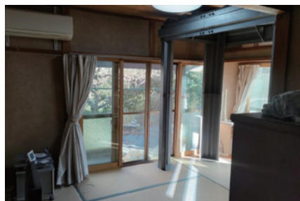
施工事例（まもルーム）
