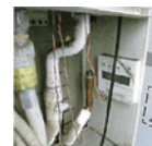
給湯器二次側配管切り離し
