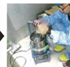
ライニング樹脂の混合・攪拌
