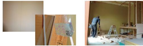
UFO-Eを採用した益城町の建設中の現場では、ボードや金物類の損傷や変状は見られず、地震から1週間後にはボード貼り作業を再開することができた。
