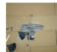
強化ビスの浮きや抜けは見られない
