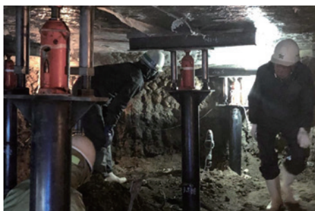
施工状況（鋼管杭圧入工法）
