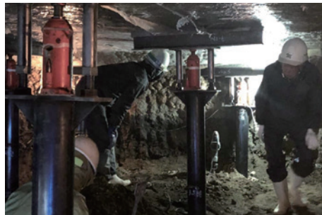
施工状況（鋼管杭圧入工法）
