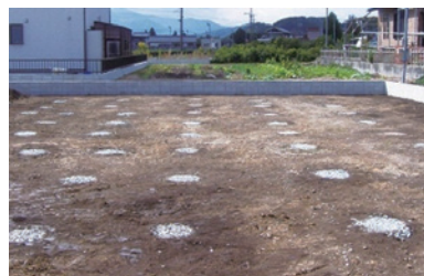
施工後の地盤（住宅）
