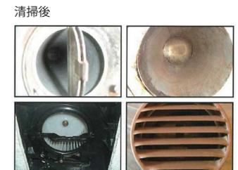
ダクト内部のほか、ベントキャップ（排気口の蓋）や換気扇、キッチンのレンジフード、さらに二層管のダクトやファイヤーダンパーの清掃にも対応している。
