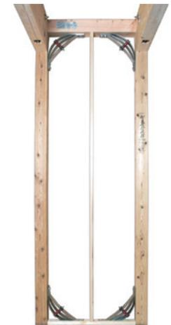
円球の形状記憶＝復元機能により、一般的な制震装置の弱点である「累積変形」を解消し、構造躯体の耐久性を大幅に延ばすことができる。
