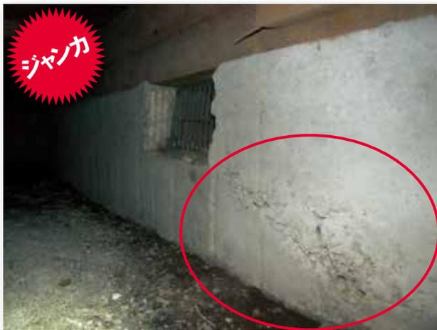
▲基礎内部に発生したジャンカ。コンクリート打設時の不良によって生じ、密度が低いため、より水分や炭酸ガスを浸入させやすい。
