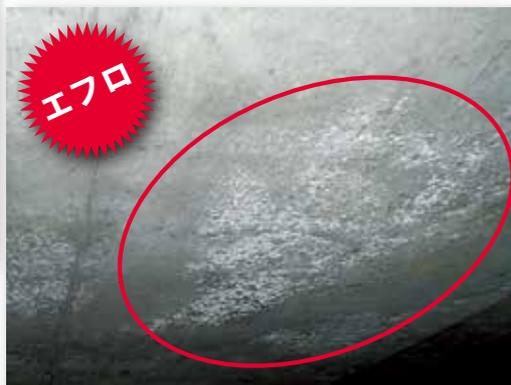
◀天井面に現れたエフロ。内部に水の通り道があるため、鉄筋が腐食している可能性が高い。
