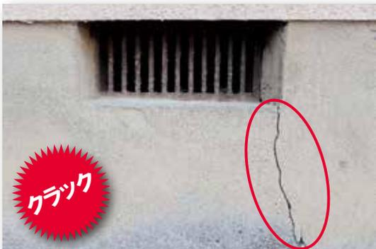
▲基礎外部の開口部に生じたクラック。雨水や炭酸ガスがクラックを通過して入り込みやすい。
