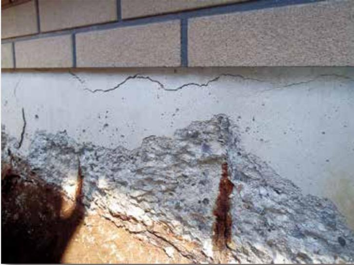
【内部鉄筋が発錆・膨張して、かぶり剥落している基礎】
