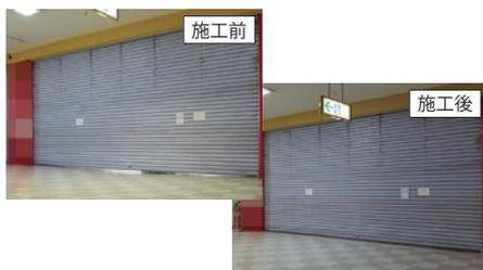
ショッピングモールでの施工例。地震により床が沈下したため、シャッター下に隙間が生じていたが、夜間工事で沈下修正を行うことで営業を止めずに施工が完了。
