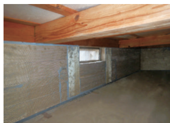
アラミド繊維シート貼付工
