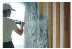
断熱材を霧状の水の中を通過させ、風圧をかけて壁に吹き付 ける「ウォール・スプレー®」。小さな隙間や手の届かない 空間も埋めることができるので、高い断熱性能を発揮する。
