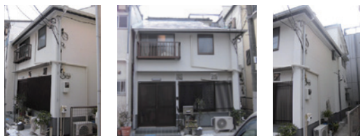
〔施工後〕耐震と景観の両立
