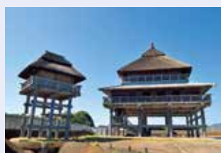
国営公園 吉野ヶ里遺跡 防蟻防水工事
