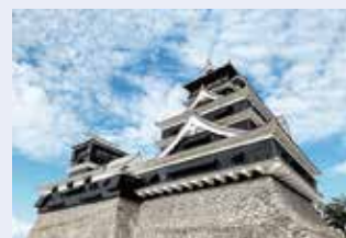
熊本城跡 復元工事
