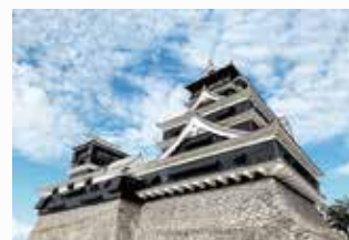
熊本城跡 復元工事
