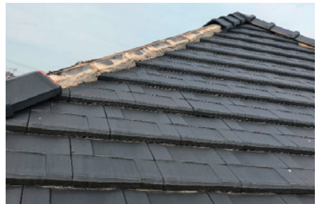
写真4：瓦の破損
