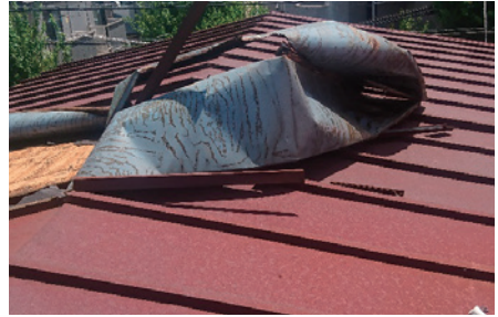
写真2：銅板製屋根の破損
