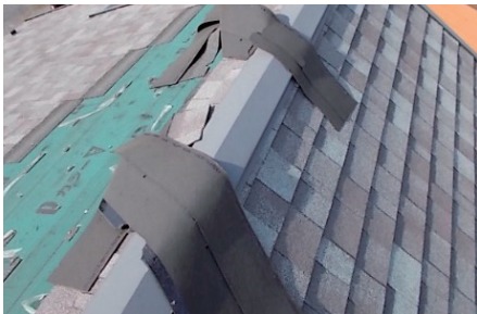
写真3：アスファルトシングル破損
