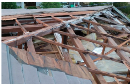
写真6: 野地板の劣化
