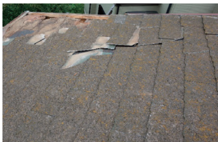
写真8: ケラバの破損
