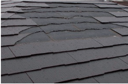
写真1：化粧スレートの破損
