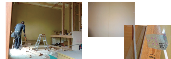
地震から1週間後にはボード貼り作業を再開 ボードや金物類の損傷や変状も見られなかった
