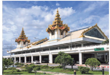
施工例（ミャンマー・マンダレー国際空港）
