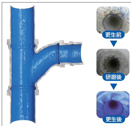
施工後の管内と各施工工程での管内状況
