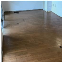
サンドペーパーを使用して、床の凹凸や小さい傷を補修。深い傷などにはパテを充填し、ペーパーで平面にする。
