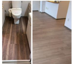
シート接着後、既存の目地に沿ってカット、目地入れ。シートが破損した場合も、そのシートのみ張り替えが可能でメンテナンスも容易。
