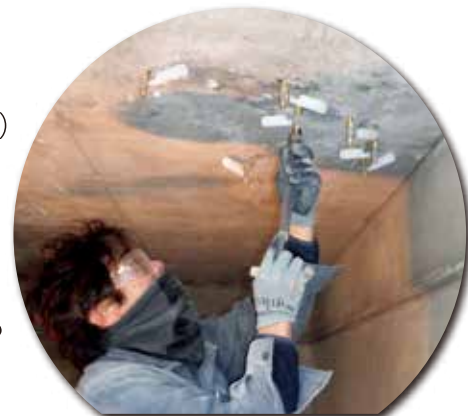
【天井面の止水施工例】
