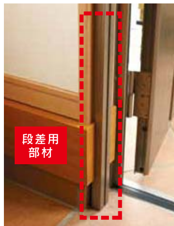
段差用部材を使うことにより段差を解消
