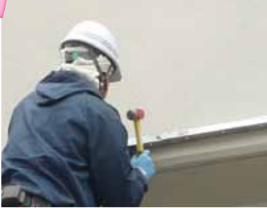
アングル設置 (建築工事)
