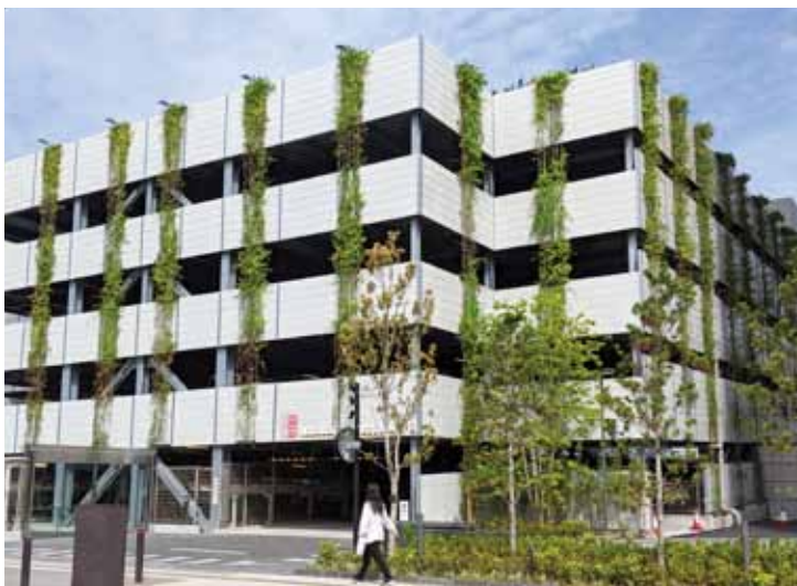
立体駐車場壁面：施工後1年3ヶ月
