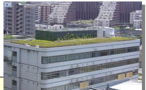
屋上壁面での緑化(東京都)
