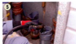
自社製ジェットローター等による管内の研磨・清掃
