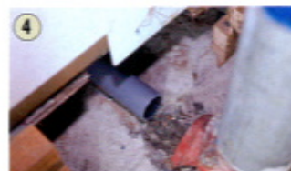
横枝管の抜管
