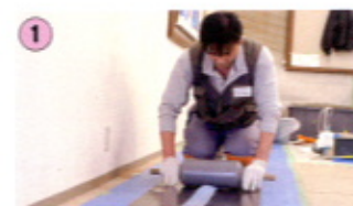
芯材にエポキシ樹脂を含浸
