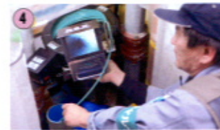
CCDカメラを使ったライニング後の管内チェック
