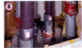
立管を本復旧し、排水制限は解除
