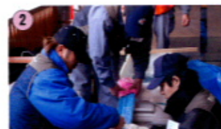
ライニング材を反転機に装着
