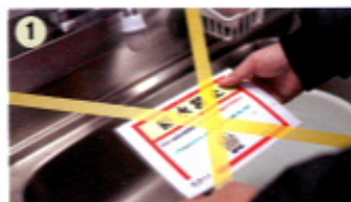
専用シール等による排水制限部分の表示作業
