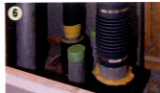
配管の仮復旧後、排水制限は解除
