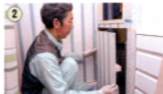
工事対象排水管前の壁の開口
