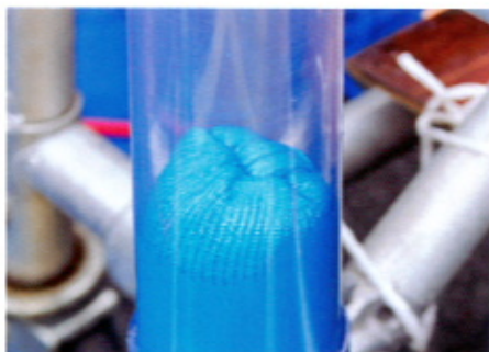
エアの圧力により、反転しながら管内を突き進む ライニング材。
