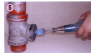
継ぎ手部分の加工・仕上げ
