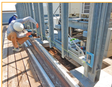
ストリンガーブラケット設置
