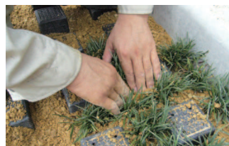
⑦植物植付・散水
