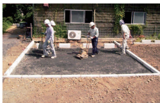
①路盤整正転圧
