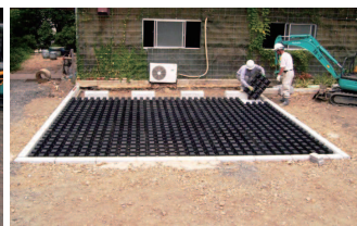
④GTPパネル設置
