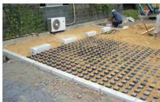
⑤客土敷均し
