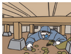
①床下のガラ出し・整地
