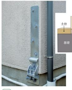
施工箇所の状況により 下部プレートは最大20mmの範囲で 段差の調整が可能。
