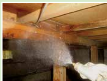
②木部防蟻処理
